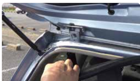
⑧バックドアへ配線
