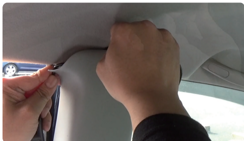
⑤センターピラーに配線
